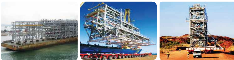
〈그림 3〉 분할 모듈의 운반 및 하역(Karratha project)
