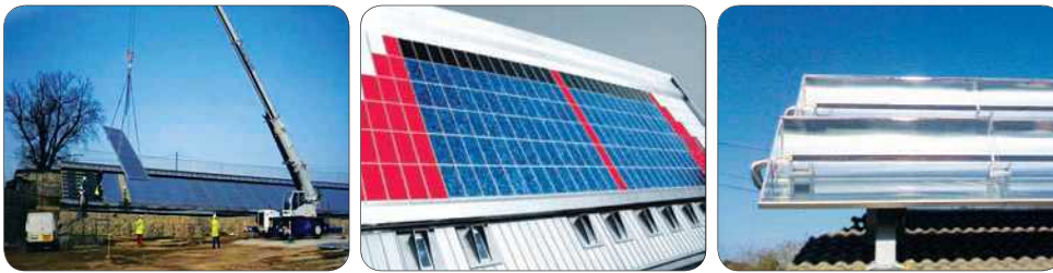
〈그림 3〉 PVT 모듈의 설치 사례(왼쪽부터 (a), (b), (c))
