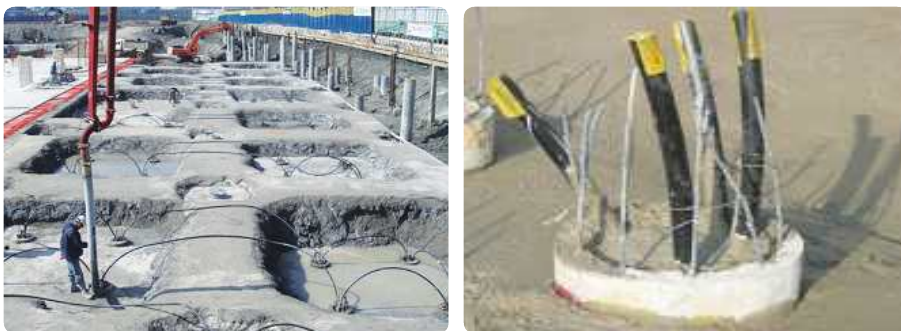
〈그림 1〉 기성 파일(PHC pile)을 활용한 지중열교환기
