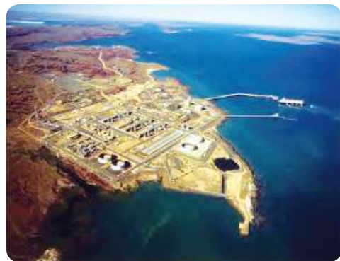
<그림 1> Karratha LNG플랜트 전경
